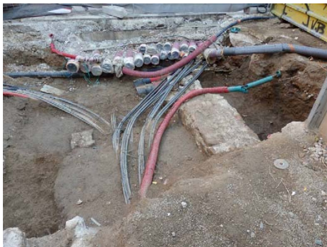
Vista del cablejat UE 105
