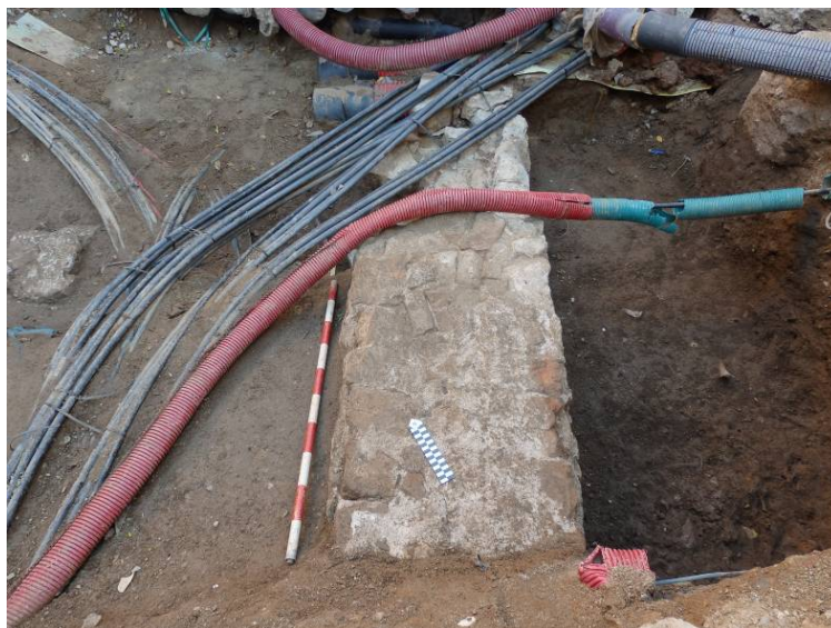
Vista de l'estructura UE 109
