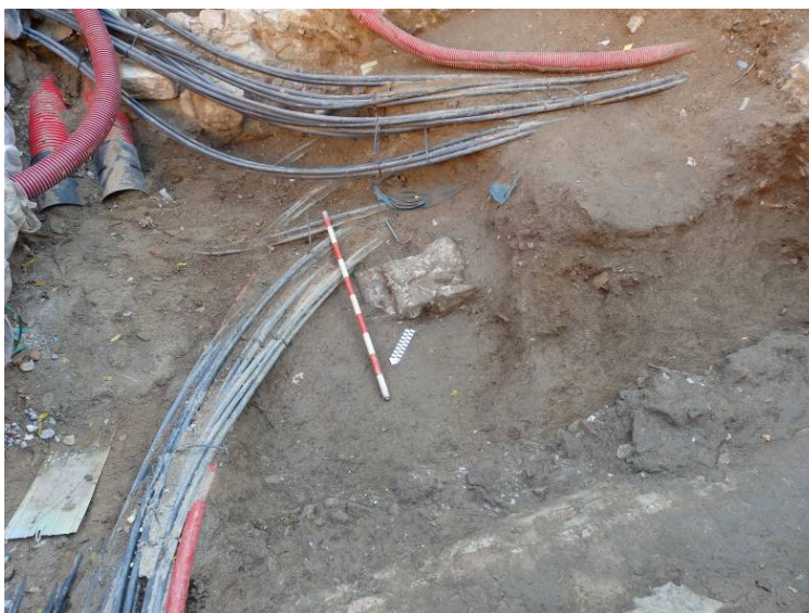
Vista de l'estructura UE 111
